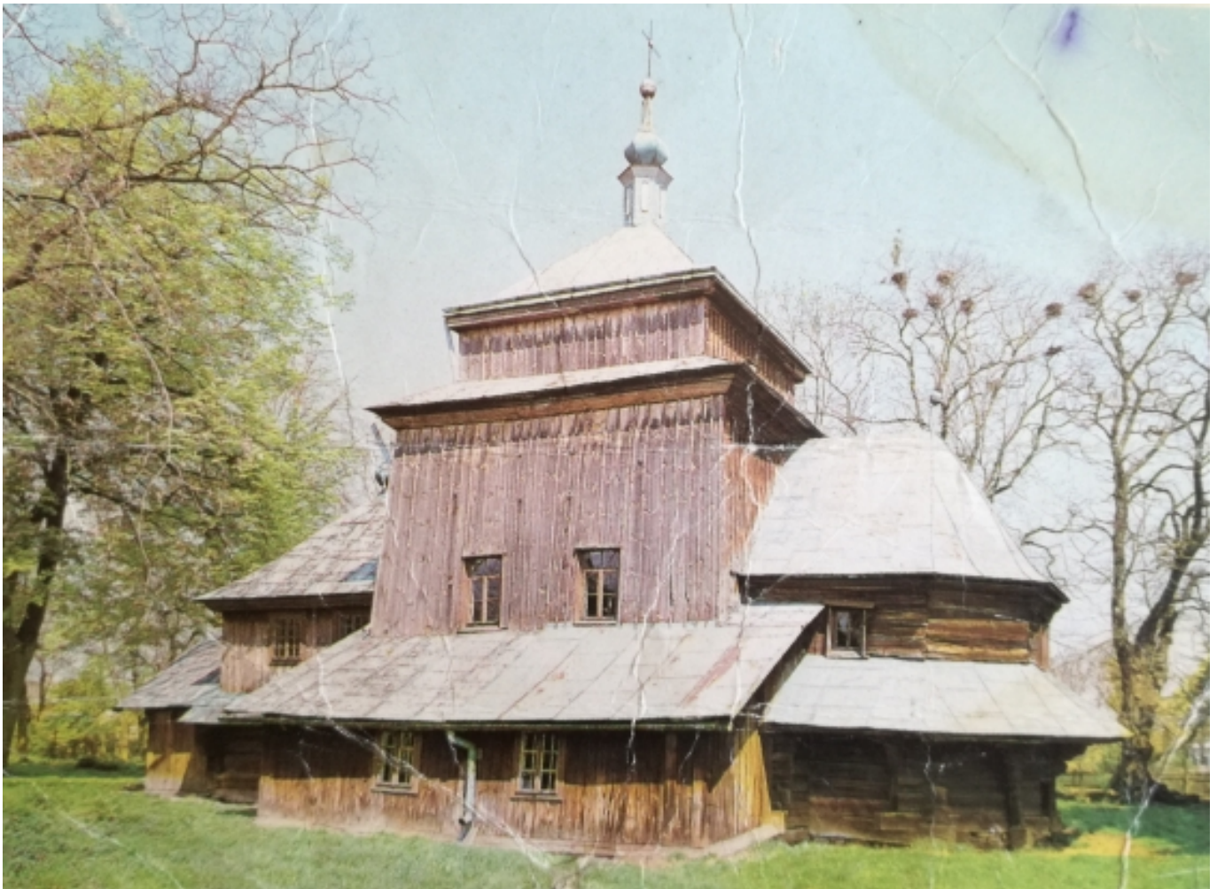
Cerkiew w Leżachowie przed remontem. Zdjęcie ze zbiorów rozmówcy. Skan Zofia Broła
