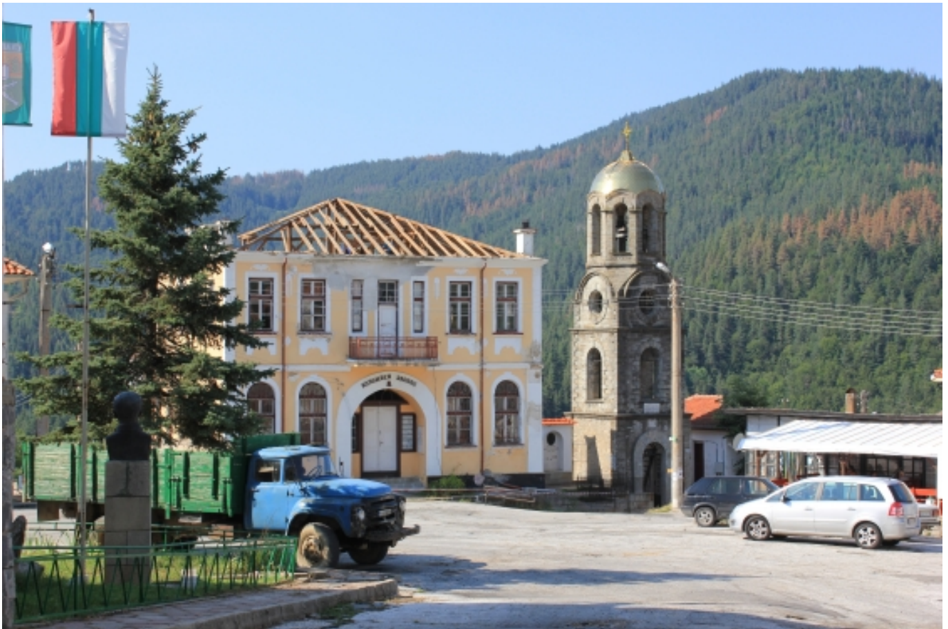
Centrum wioski Slaveino (obw. Smolian): galeria sztuki i dzwonnica.
