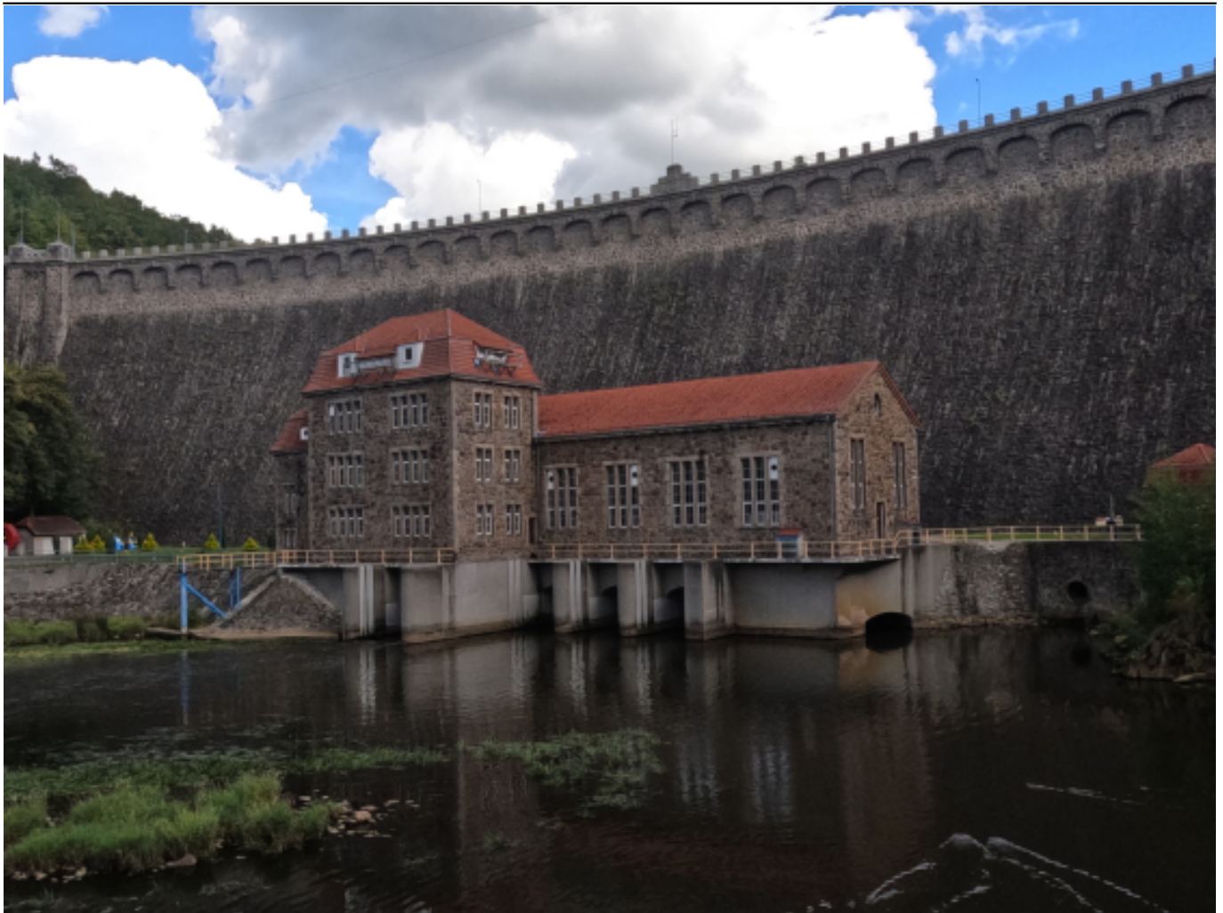
Bóbr, Tama w Pilchowicach, Fot. Małgorzata Owczarska
